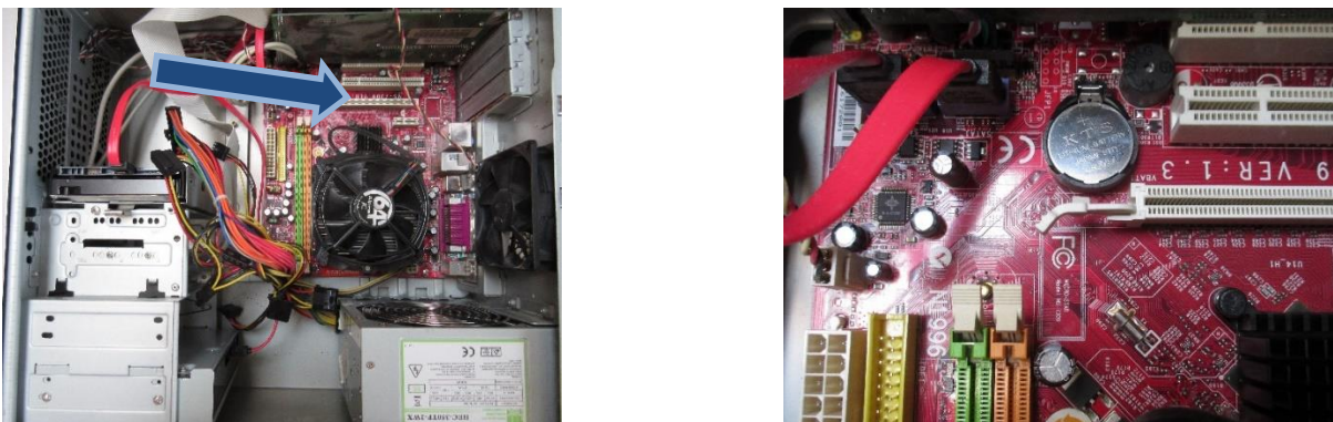
Abbildung 14: Stützbatterie Typ CR 2032, 3 Volt auf PC-Platine
